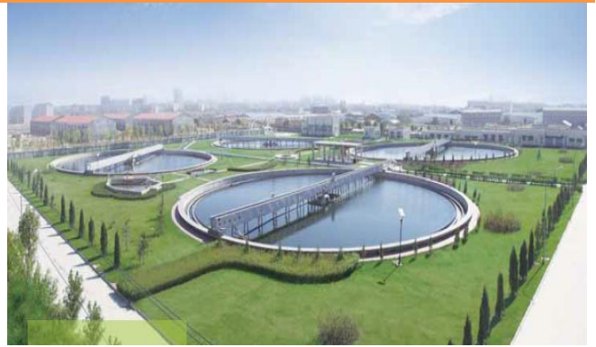
图表32 公司济南污水处理项目
